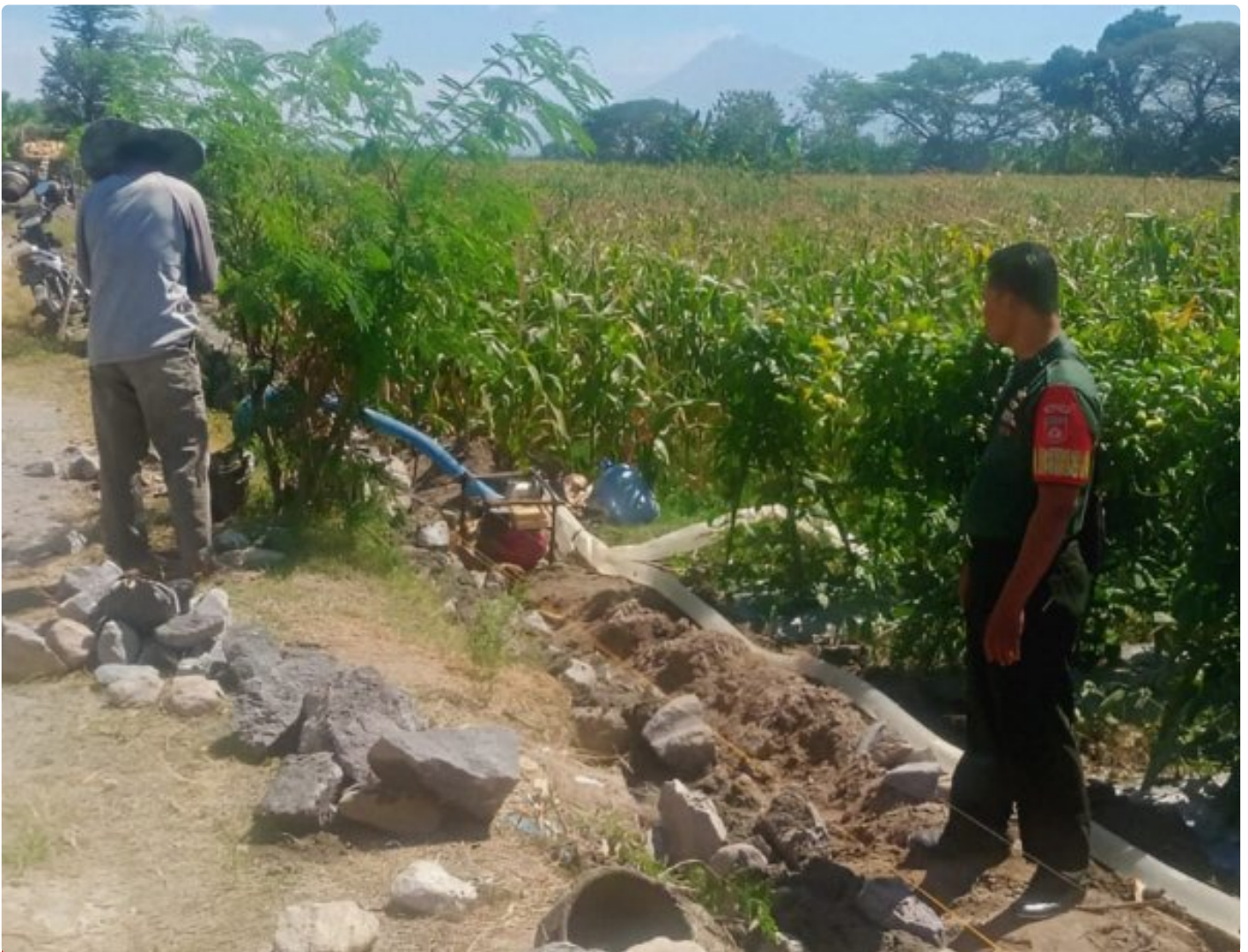
Wujudkan Kemanunggalan TNI dan Rakyat, Babinsa Ceper Bantu Buat Talud
