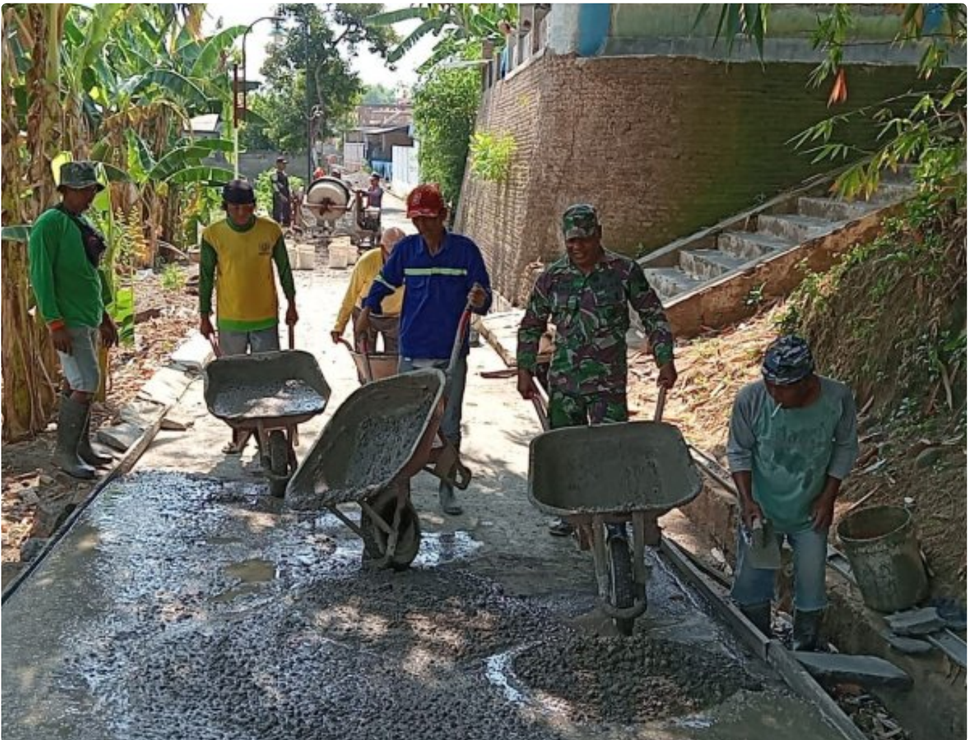
Tingkatan Infrastruktur, Babinsa Bersama Warga Karya Bakti Cor Jalan Desa Wadunggetas Klaten
