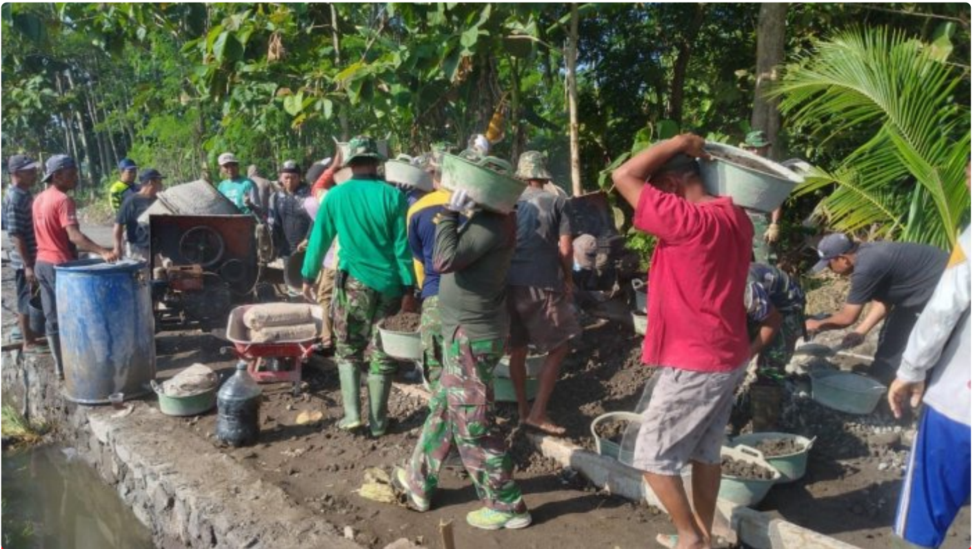
Babinsa Kodim Klaten Gotong Royong Betonisasi Jalan Program TMMD
