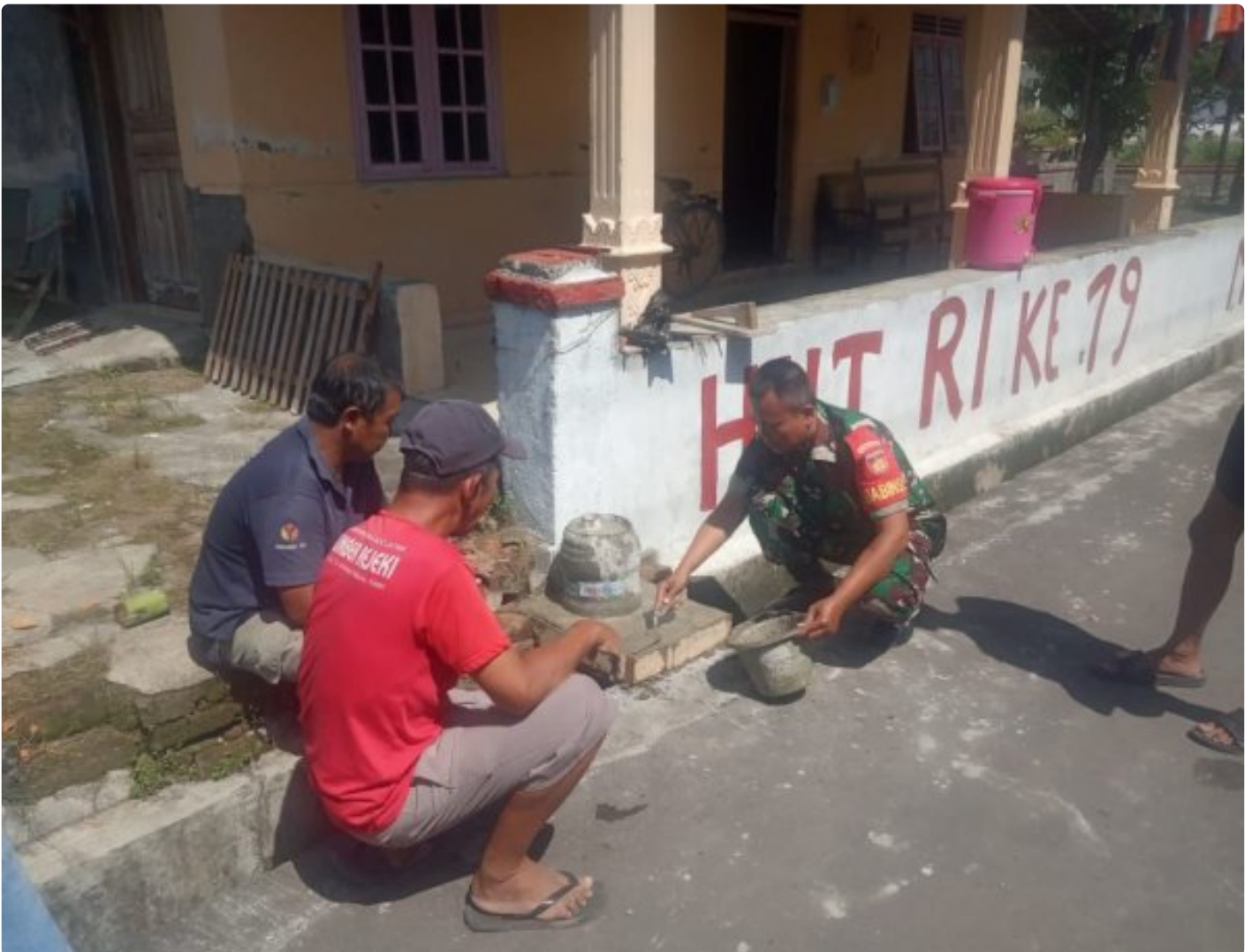
Babinsa Desa Ketandan Klaten Bersama Warga Karya Bakti Pemasangan Tiang Lampu Penerangan Jalan
