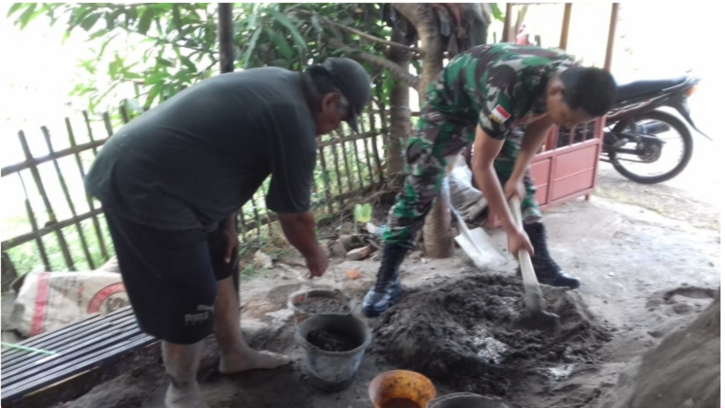
Babinsa Ceper Bantu Warga Renovasi Rumah Binaannya
